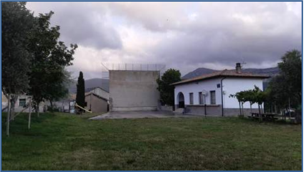
Fotografía. 4. Punto de encuentro en Zabalza. Frontón descubierto.
